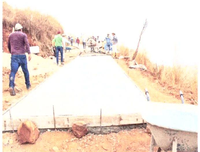
*Imagen 36.- supervisión en la localidad de La Pitillera donde se está construyendo sobre la brecha un tramo de Concreto Hidráulico*
